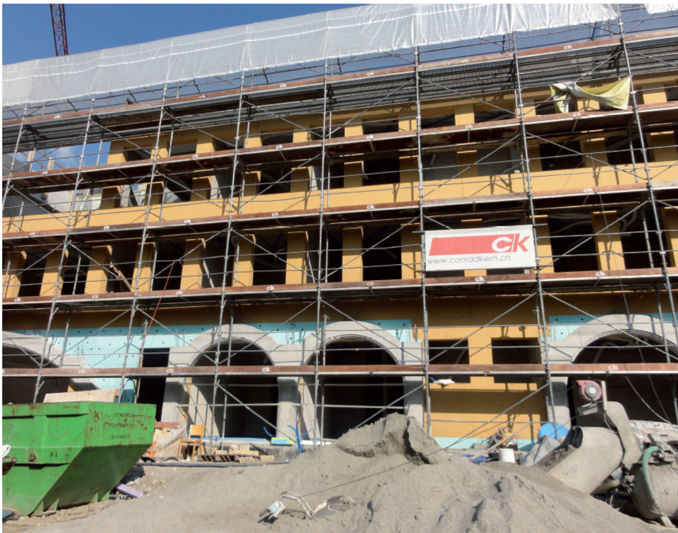
Cfr. foto 1 - Fondazione Madonna di Re Bellinzona dettaglio tamponamenti di facciata in legno intelaiato
